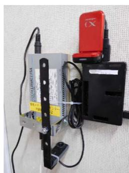
図 3. メディアコンバータ監視システムの設置例
